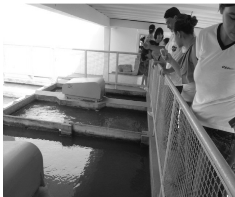
Foto 1. Alunos do CEPIF observando os processos de tratamento da água na SANEAGO de Pires do Rio. Autor: DIAS, Cristiane (2013)
