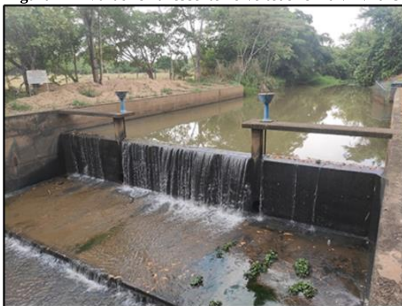
Figura 11 - Vazão remanescente no vertedor em 04/11/2019.
