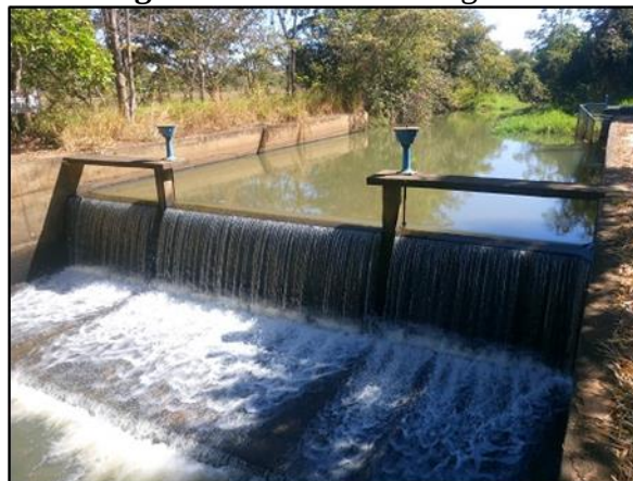
Figura 5 - Vertedor retangular.
