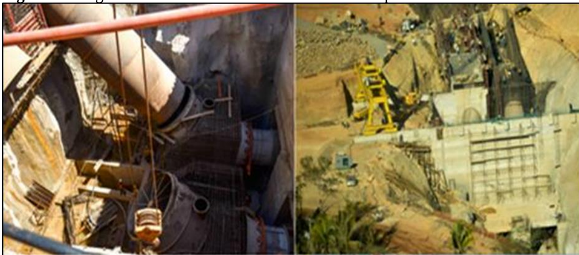
Figura 3: Imagem da obra da PCH Santo Antônio do Caiapó
