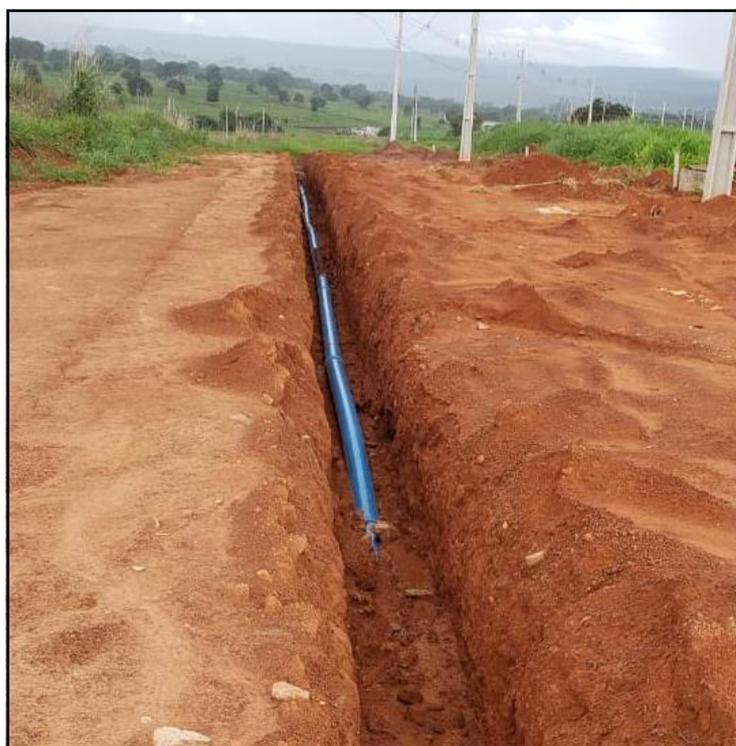
**Figura 16** – Instalação de equipamentos para a distribuição de água potável.
