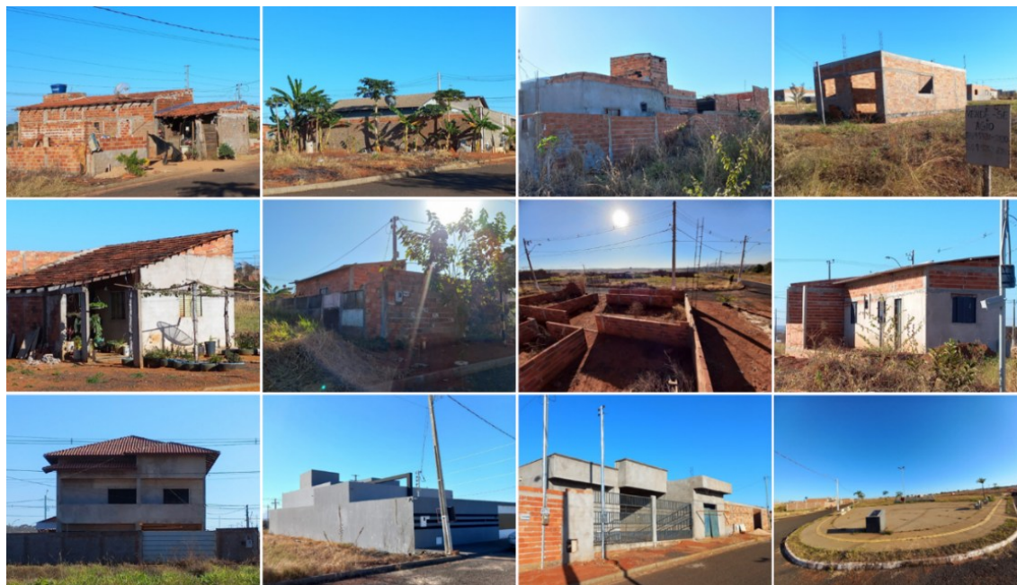
Figura 19 – Tipologia arquitetônica do loteamento Nova Iporá – jun. 2023.
