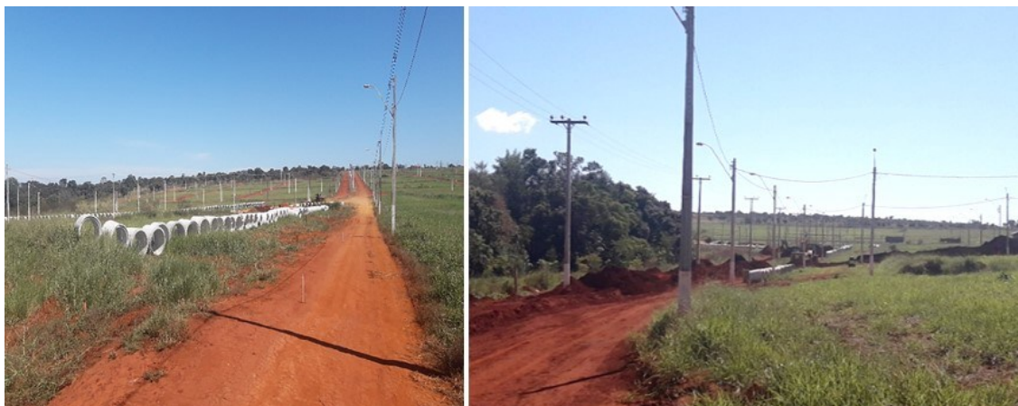
Figuras 13 e 14 – Instalação de equipamentos para ligação da rede pluvial – 22 maio 2019.
