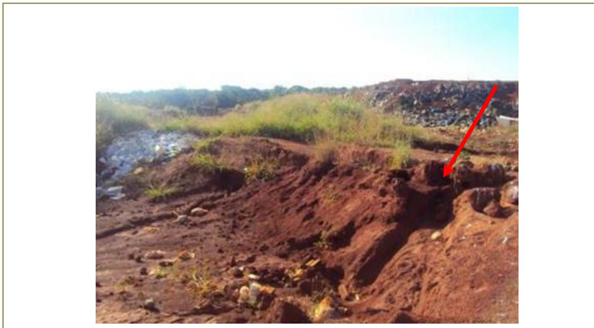
Figura 2 - Sulcos abertos nos taludes por ação de enxurradas.
