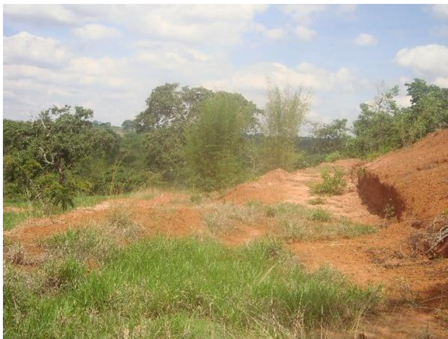
Fotografia 2 - Construção de terraços para conter o processo erosivo - 2006
