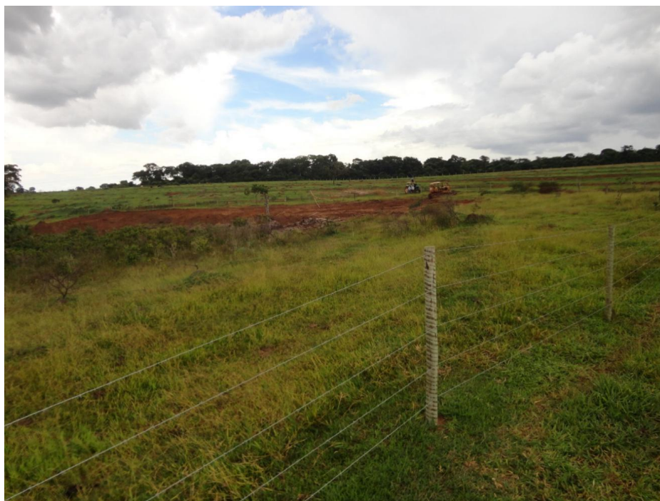
Fotografia 5 - Construção de terraços para a contenção de processos erosivos e cerca para a proteção da nascente
