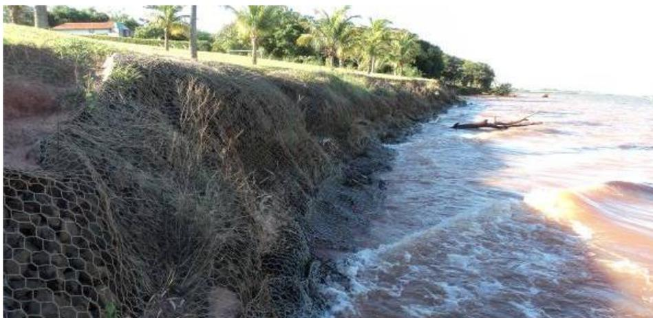
**Figura 8** - Contenção com gabiões é a melhor opção para a Fazenda de Lazer.
