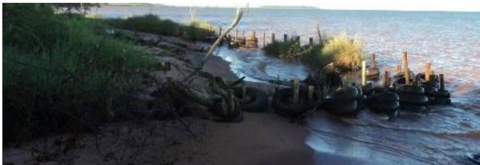
**Figura 7** - Contenção com pneus e estacas de madeira.
