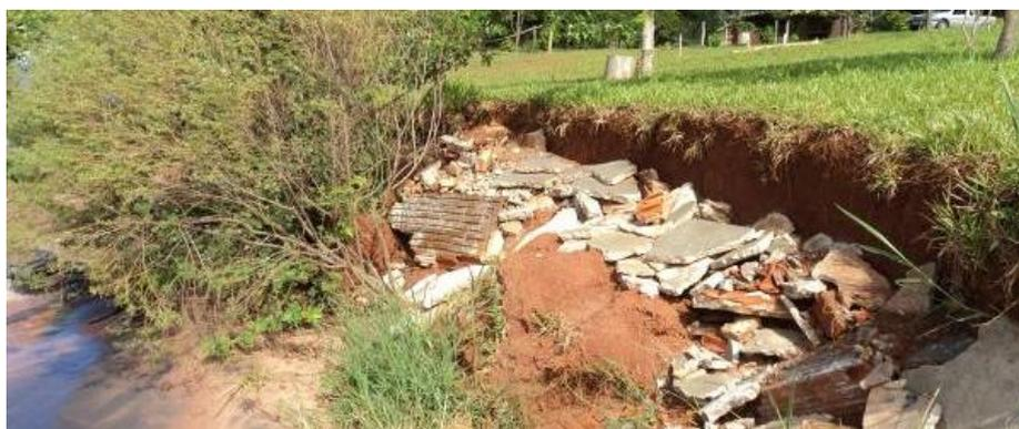
**Figura 6** - Resíduos de construção utilizados na tentativa de conter o avanço da água sobre a margem.
